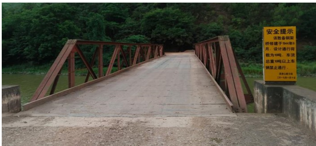
图 9 胜备桥整体照片
