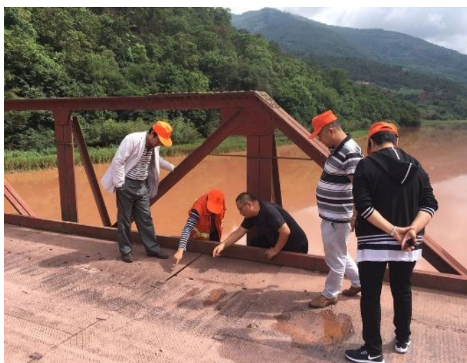
图 11 胜备桥检修照片
