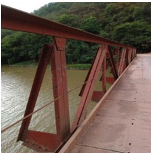
图 10 胜备桥主桁架防侧向失稳构造
