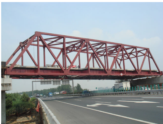
图 5 有风撑桁架桥
